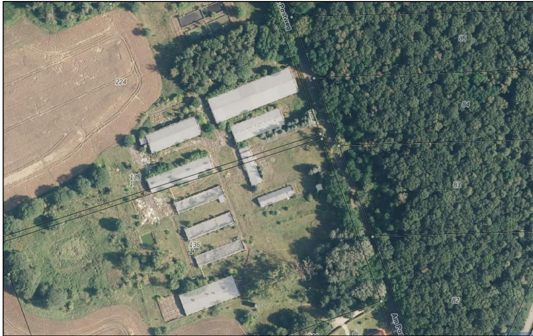
Abbildung 1: Luftbild der untersuchten Flurstücke mit Darstellung der Gebäude- und Bausubstanz, ©GeoBasis-DE/LGB, dl-de/by-2-0, 22.04.2020
